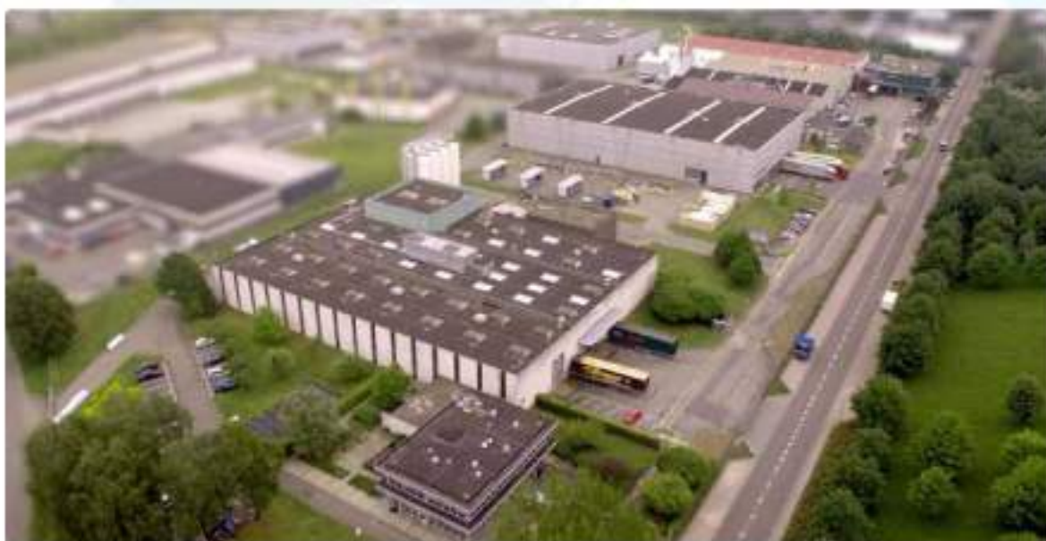
Завод по производству удобрений с контролируемым высвобождением компании ICL в г. Херлен, Нидерланды.
